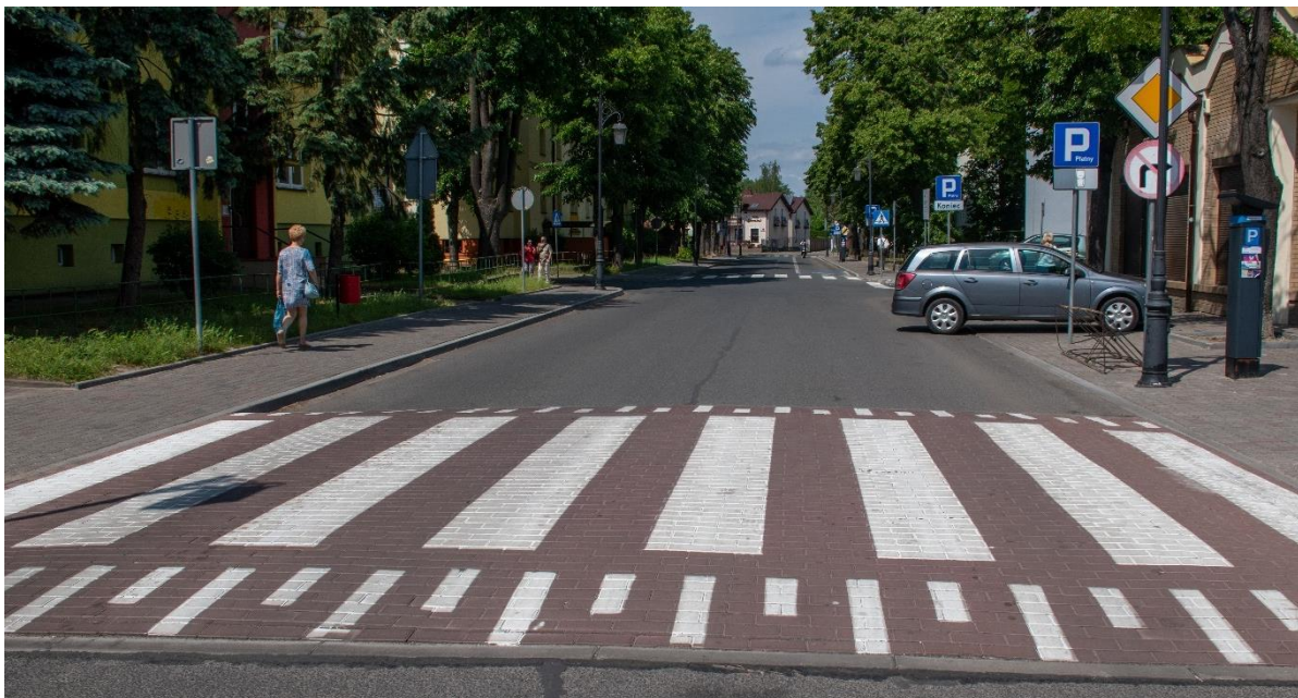
Fotografia 4. Przejście dla pieszych na ul. Strażackiej
