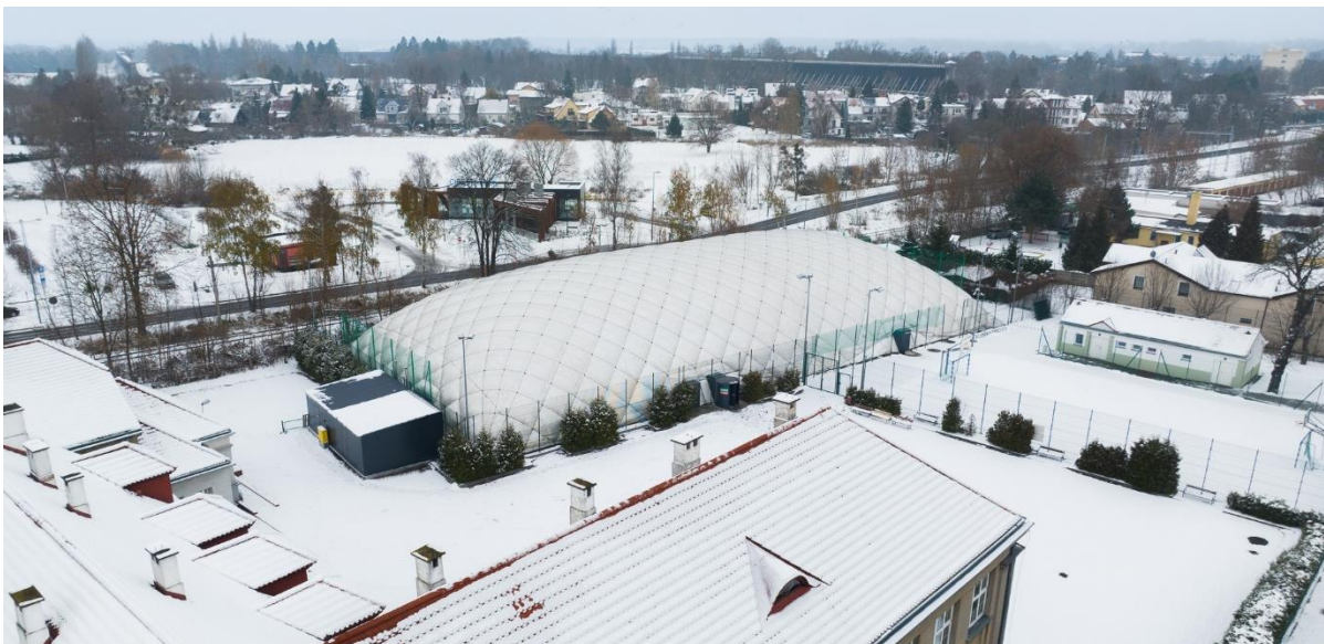
Fotografia 15. Hala Pneumatyczna nad orlikiem przy Szkole Podstawowej nr 1
