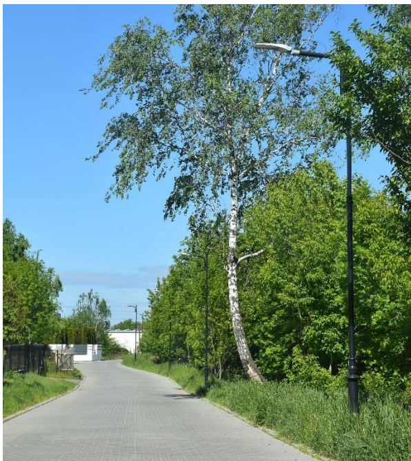
Fotografia 5. Budowa nawierzchni ul. Rolnej
