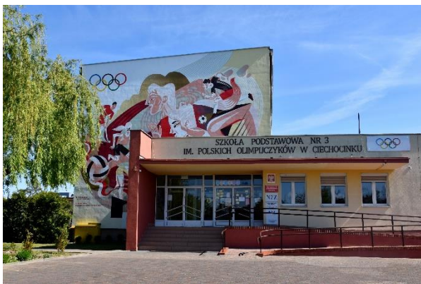
Fotografia 7. Renowacja ściany frontowej wraz z murem w Szkole Podstawowej nr 3
