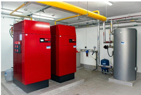
Fotografia 8. Wymiana źródła ciepła w ciepłowni lokalnej Szkoły Podstawowej nr 3
